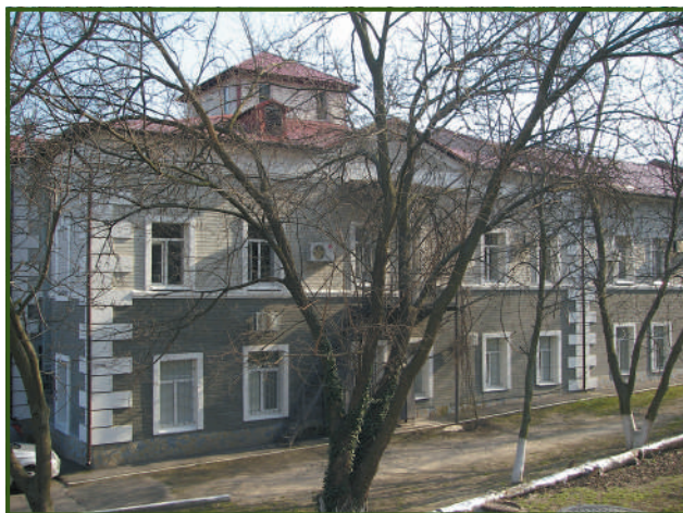
Колишня будівля общини сестер-жалібниць і лікарні Червоного Хреста (до 1910 року). Нині — Дніпропетровське обласне бюро судово-медичної експертизи (площа Соборна, 14). Сучасне фото
